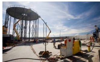
LNG tank construction
